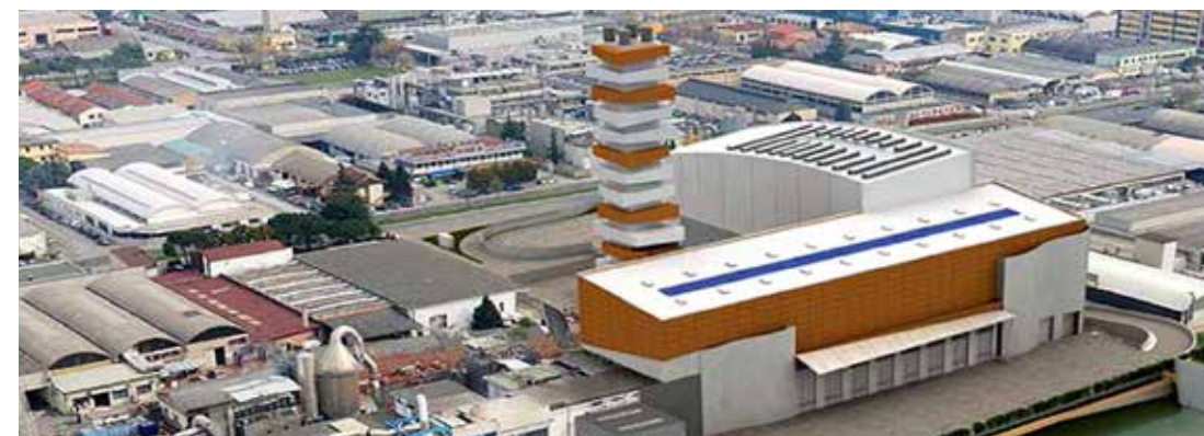
Termovalorizzatore di Padova - San Lazzaro
